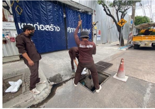
รูปที่ 33 สำนักงานเขตดุสิตมาขุดลอกตะกอนดินทรายที่อาจตกค้างในท่อระบายน้ำ
