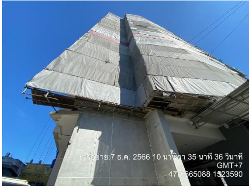
รูปที่ 14 ติดตั้งตาข่ายกันฝุ่น (Mesh Sheet) ปิดคลุมด้านนอกโดยรอบโครงสร้างอาคาร (ปัจจุบันทำการรื้อออกเรียบร้อยแล้ว)
