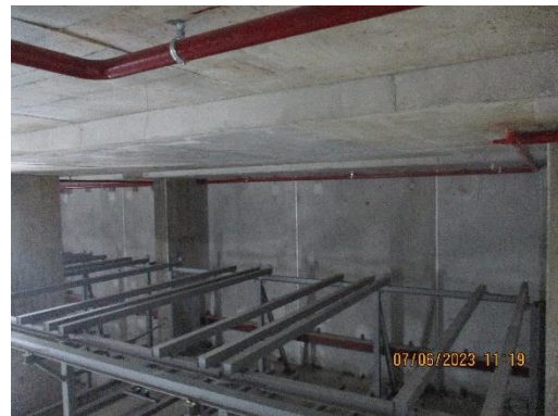
รูปที่ 26 ผนังคอนกรีตสำเร็จรูป (Precast Concrete)
