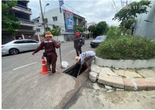
รูปที่ 33 สำนักงานเขตดุสิตมาขุดลอกตะกอนดินทรายที่อาจตกค้างในท่อระบายน้ำ
