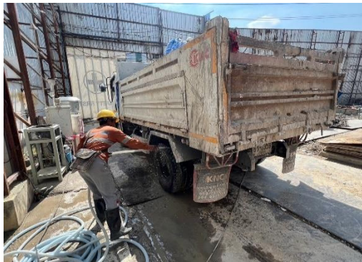
รูปที่ 19 ทำความสะอาดล้อรถก่อนออกจากโครงการ (ปัจจุบันทำการรื้อออกเรียบร้อยแล้ว)
