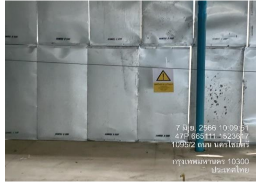
รูปที่ 23 ติดตั้งแผ่นกันเสียง Bloxteq ล้อมรอบอาคารชั้นที่กำลังก่อสร้าง (ปัจจุบันรื้อถอนเรียบร้อยแล้ว)
