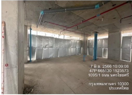
รูปที่ 23 ติดตั้งแผ่นกันเสียง Bloxteq ล้อมรอบอาคารชั้นที่กำลังก่อสร้าง (ปัจจุบันรื้อถอนเรียบร้อยแล้ว)
